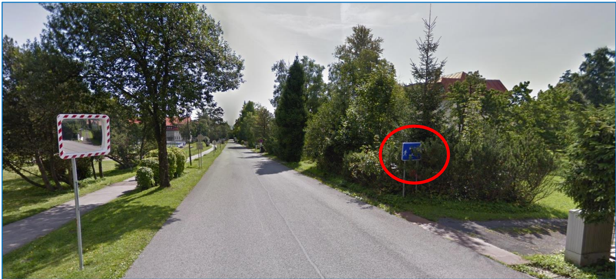
Obrázok 70 Absentujúce kvalitnejšie stavebné vyhotovenie obytnej zóny v Tatranskej Lomnici
